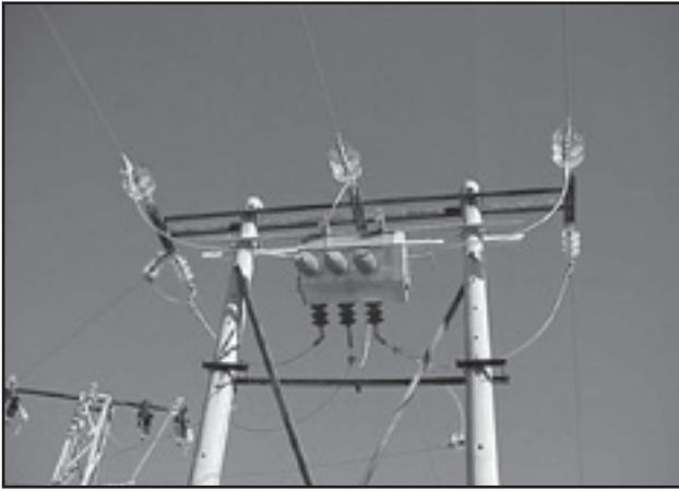
Interruptores SF6 Interrupteurs SF6 / SF6 Switches
